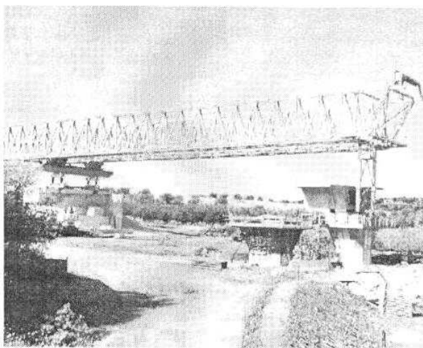
Il cantiere per la costruzione del viadotto Scardino
